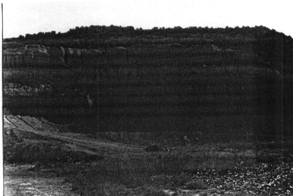
Frente de explotación de arcillas en las proximidades de Cisterniga. (Est. 230)
